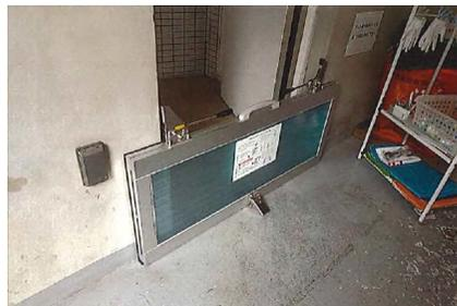
ゴミ置場に隣接するエントランスへの浸水を防ぐ止水板
