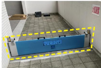
駐輪場入口と、隣接する機械室への浸水を防ぐ止水板
