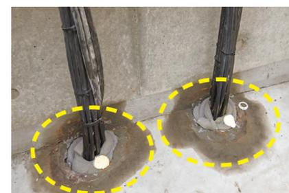
電気ケーブル貫通部の止水措置
