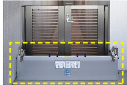
電気室・機械室への浸水を防ぐ止水板
