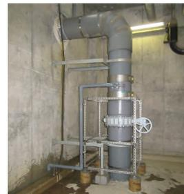
雨水貯留槽から地下電気室浸水を防ぐ緊急遮断弁の設置
