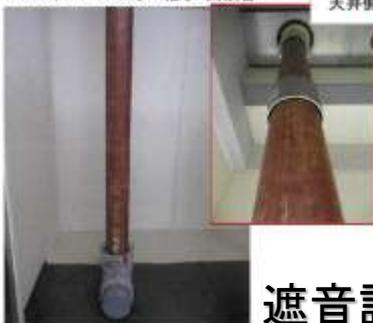
・No.A,B-3 耐火プラAD継手HG(S)+VP(遮音カバー+S)
