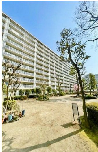
3号棟-2号棟側からの風景
