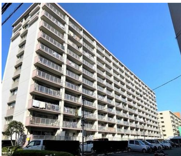
2号棟-1号棟側からの風景
