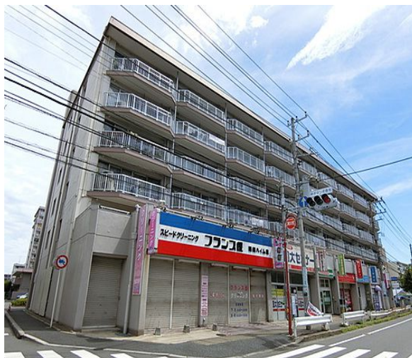
1号棟-産業道路側からの風景
