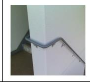
外階段と 内階段の 両側に設置。 既存不適格の 状態を解消
