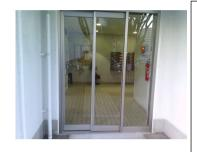
3枚戸の2枚 引き戸にして 通行幅拡大。 管理員勤務時 は開放(便利 故障、劣化、 電気代の軽減)
