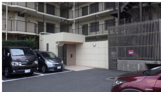
新たに設けたサブエントランス
