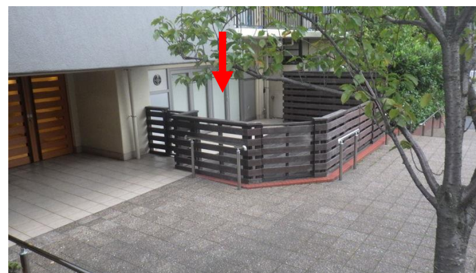
集会室と一体となったアプローチ 木柵は解放できる
