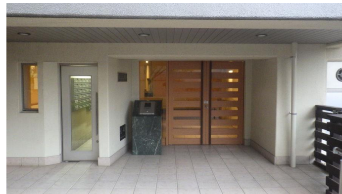
玄関 ポーチ オートロックの操作台を設置した
