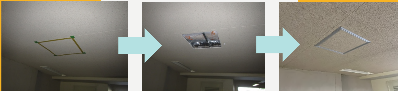
天井に後付け点検口を設置
