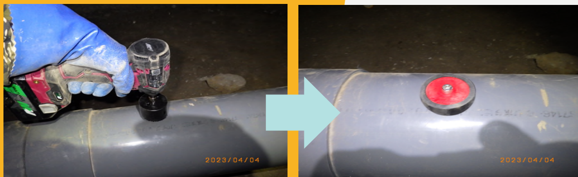
ピット内配管（塩ビ管）削孔後止水プラグ設置
