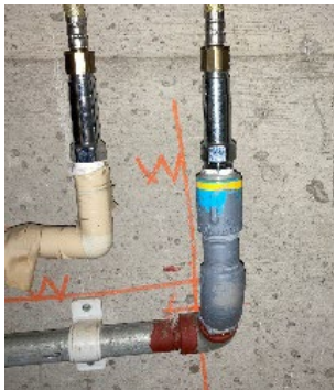
全戸調査時 点検口より 隠蔽配管撮影
