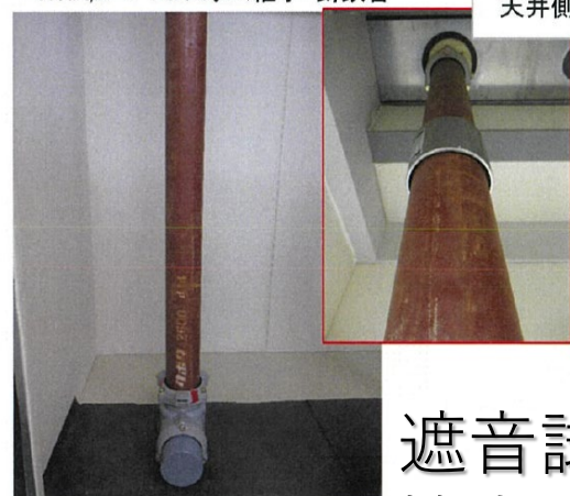
・No.A,B-4 ADスリム継手+铸铁管
