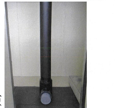
・No.A,B-3 耐火ブラAD継手HG(S)+VP(遮音カバー)+S
